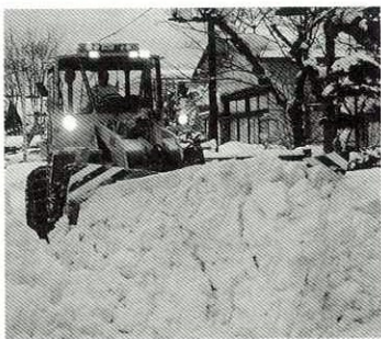
二月十日早朝、雪の山に挑む除雪ドーザー（道城地内）
