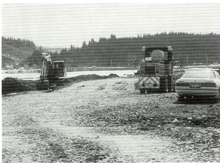
平成12年度完成を目指して着々と工事が進む三里バイパス
