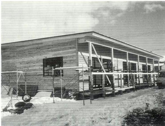
順調に建替工事が進む田の沢団地
