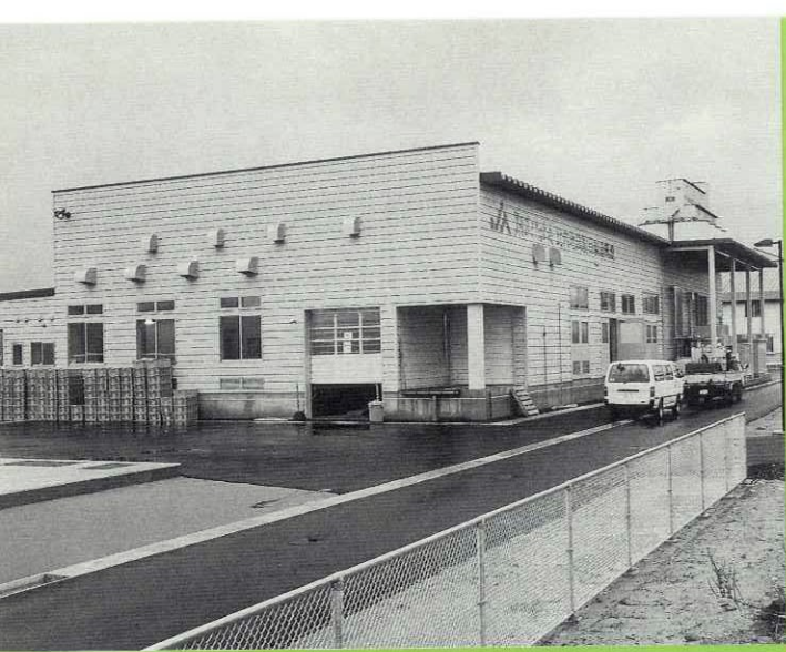
豊かな自然に囲まれた比内地鶏製品製造施設
