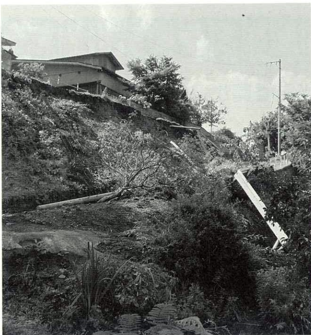
→民家裏が崩れた東根田地区
