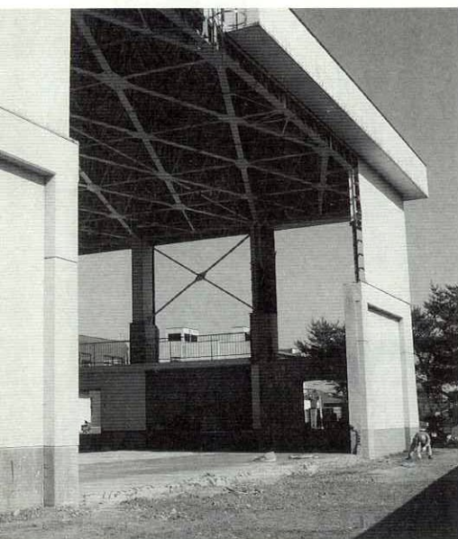
工事のつち音に夢ふくらむ町民体育館
