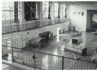
ただ今工事中です。完成すると左の図面ようになります
