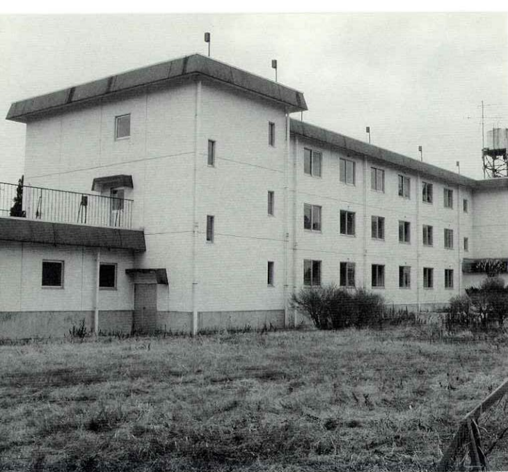
通学高校生寮として改修工事を行う 旧農業担い手研修教育センター寮
