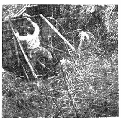
水源地の貯水コンクリート型枠据付中のところ
