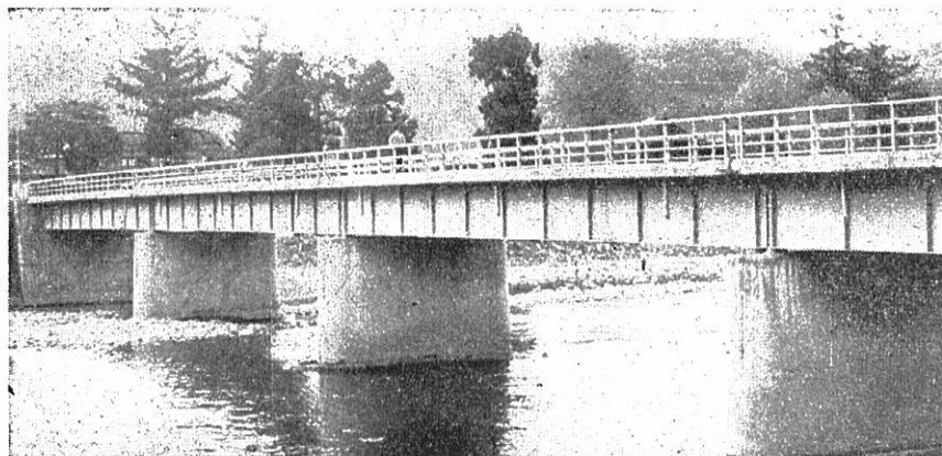
昭和32年 八幡橋竣工
