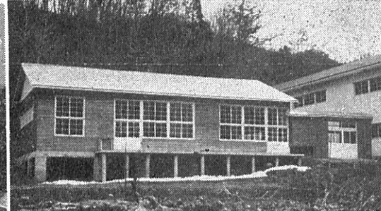
昭和39年 森吉中技術教室竣工
