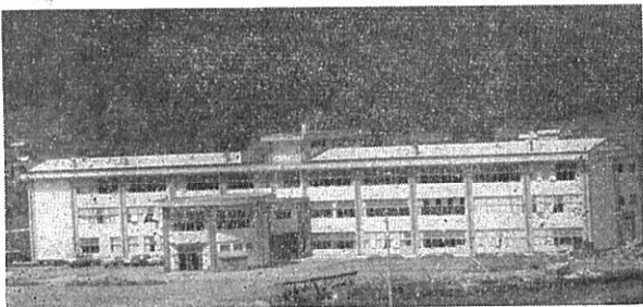
前田小学校 鉄筋コンクリート門型3階建 校舎 3,901.82㎡ (体育館3階) グラウンド 総工費 83,247千円
