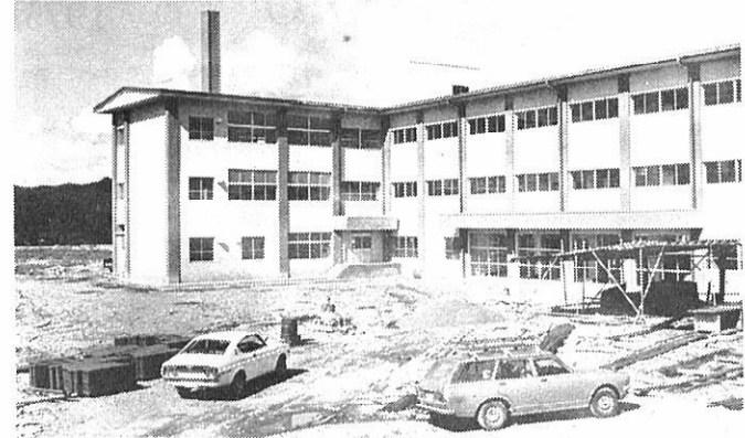
統合中学校完成部分
