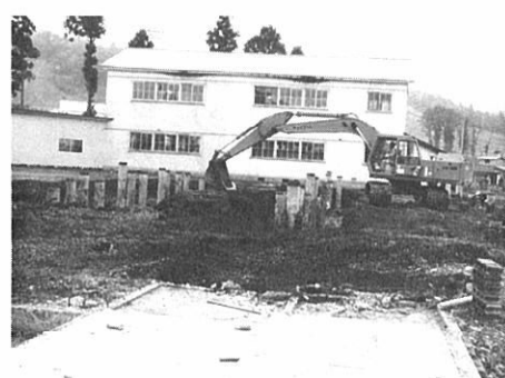
▲パイルが打ち終わった建設現場
