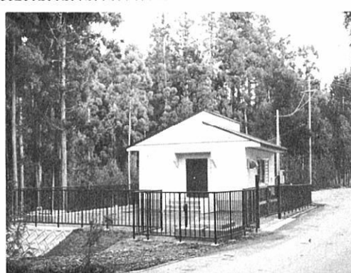
完成した給水施設
