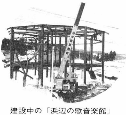
建設中の「浜辺の歌音楽館」
