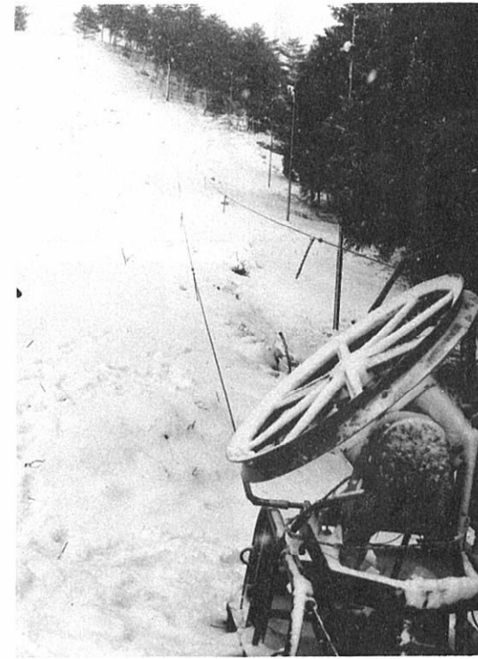
▲設置されたアンバーリフト
