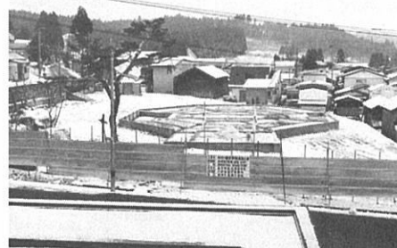
▲「浜辺の歌音楽館」建設現場
