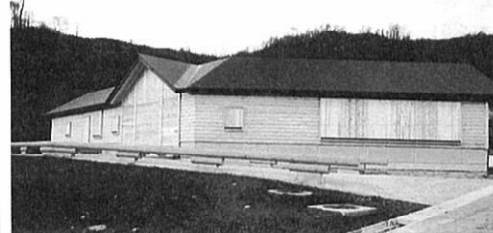
(多目的広場のトイレ)
