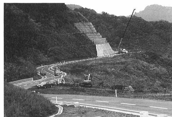
付替町道橋向地区改良舗装工事
