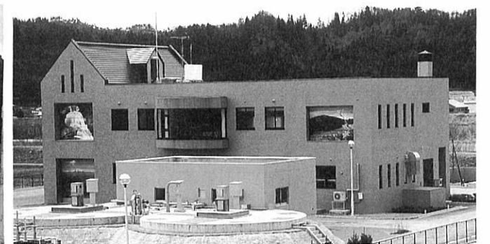
森吉町米内沢浄化センター
