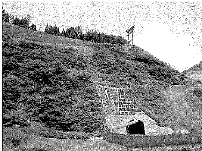
(写真-① 下段仮排水トンネル)
