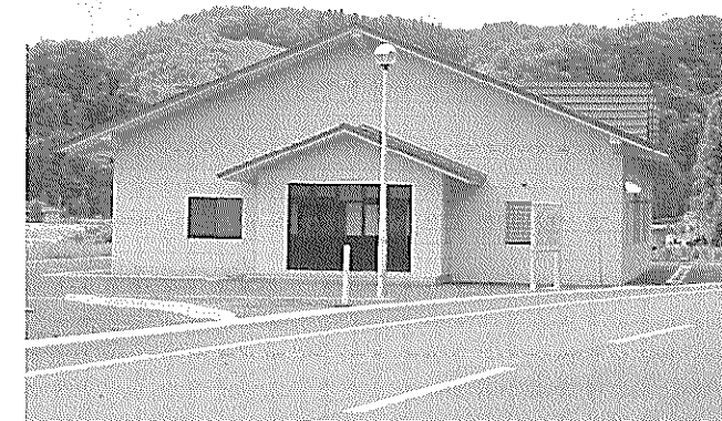
供用開始した前田地区汚水処理施設
