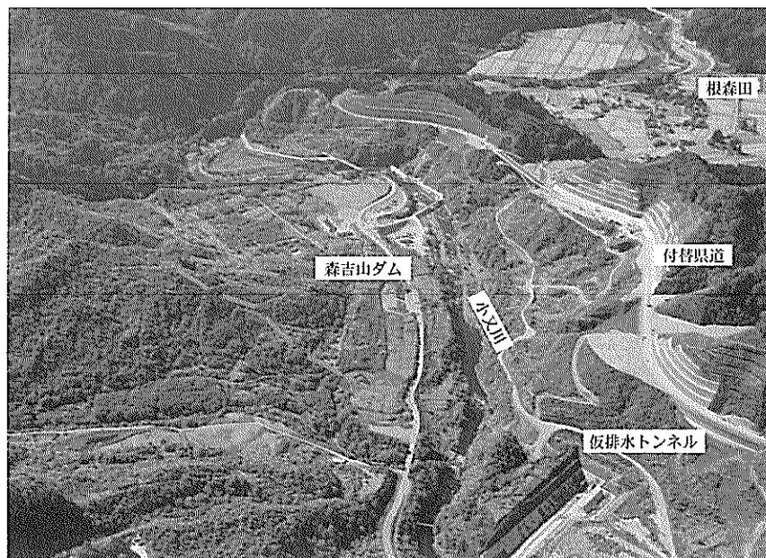
森吉山ダム建設予定地(上流側より)
