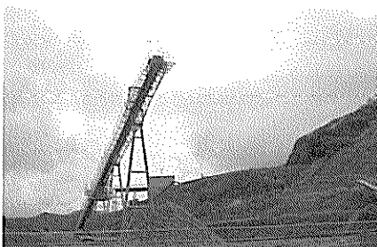
骨材製造設備(1)
