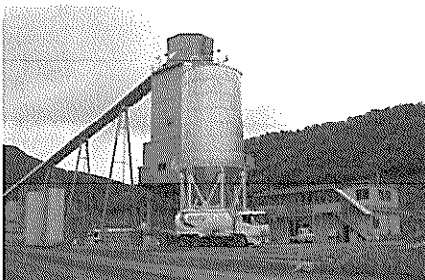
コンクリート製造設備
