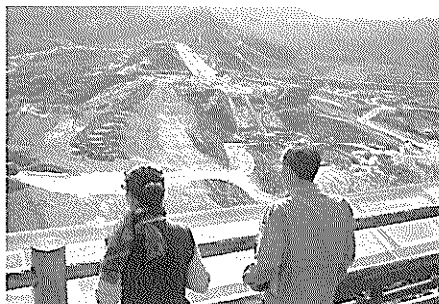
11月13日の森吉山ダム工事現場の様子
