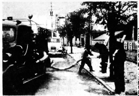
【消防栓の水位を調べる消防員】
