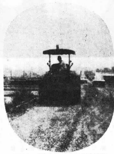
藤株・脇神地内の国道舗装
