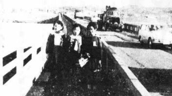
結梁歩道橋完成で交通緩和
