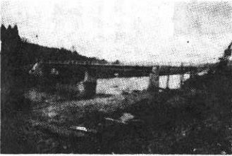
完成間近かな横瀬橋
