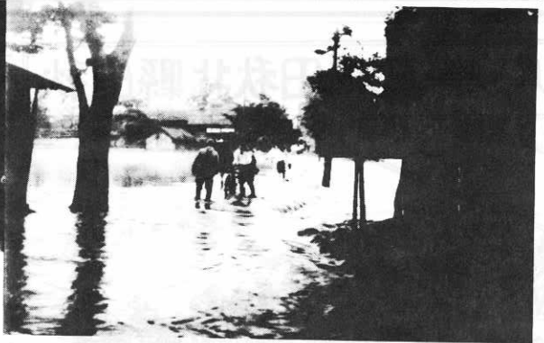
道路を洗う濁流 (舟見町)
