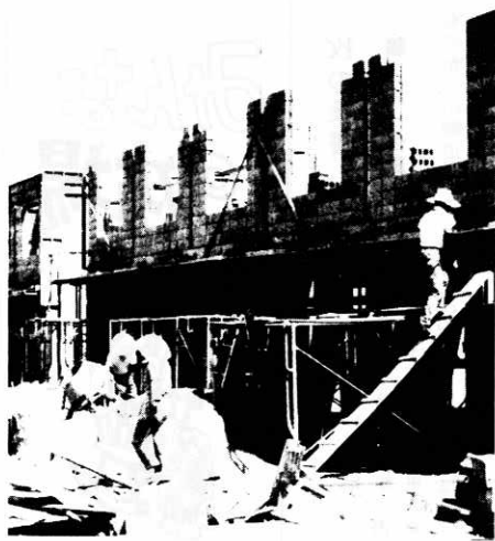
▲南鷹巣に建築中の町営住宅
