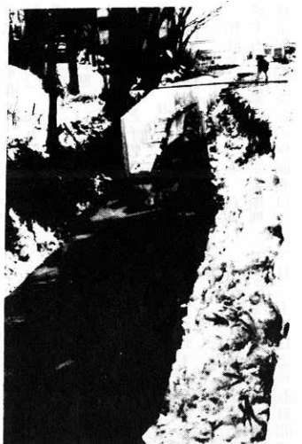
▲都市下水路工事
