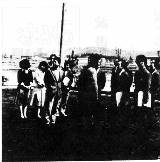
▲宅地造成地を見学する転入教員
