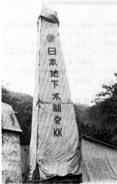
湯の岱のボーリング
