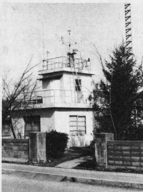
中継所として存続がきまった鷹巣気象通報所
