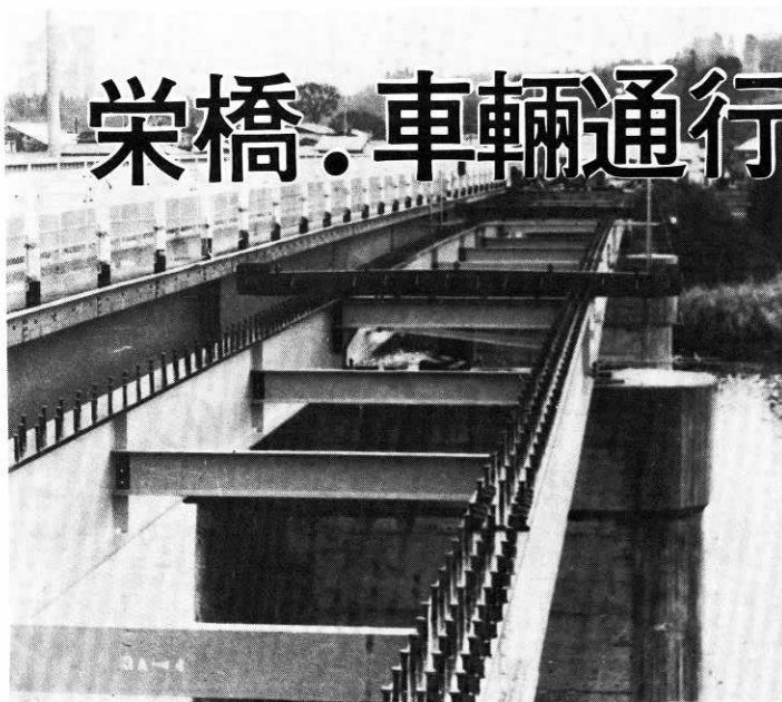
急ピッチで復旧工事中の栄橋
