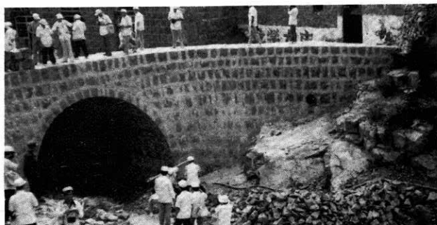
鉄砲水防止のため、人力で作った地下トンネル(大寨人民公社)
