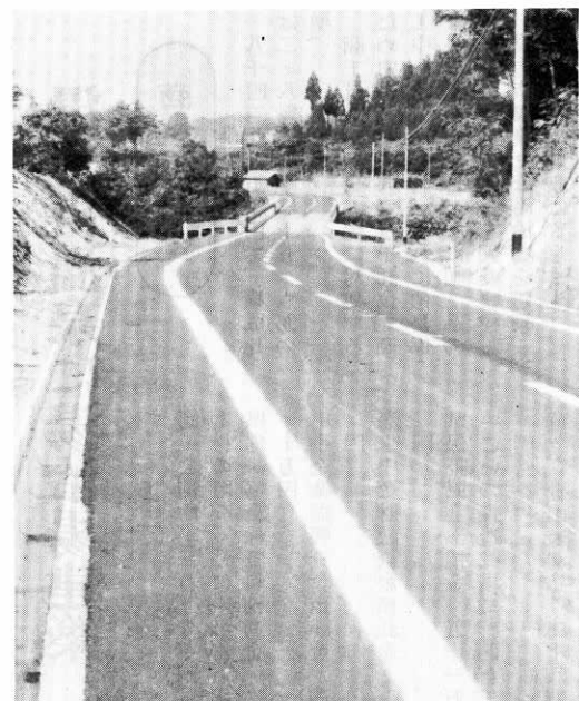
道路の改良舗装をすすめます
