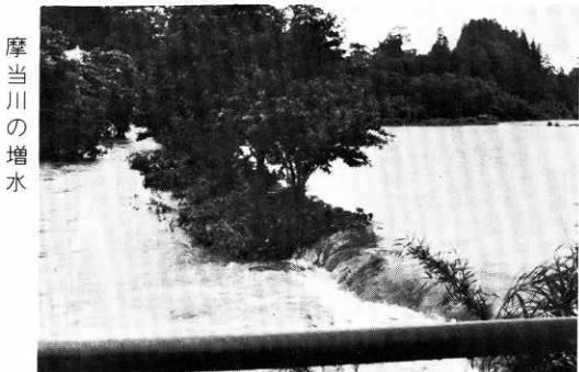
西小学校下の水路が欠壊、水田が埋没
