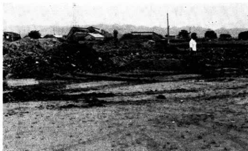
造成中の陸上競技場
