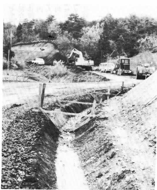
道路の改良舗装を推進します
