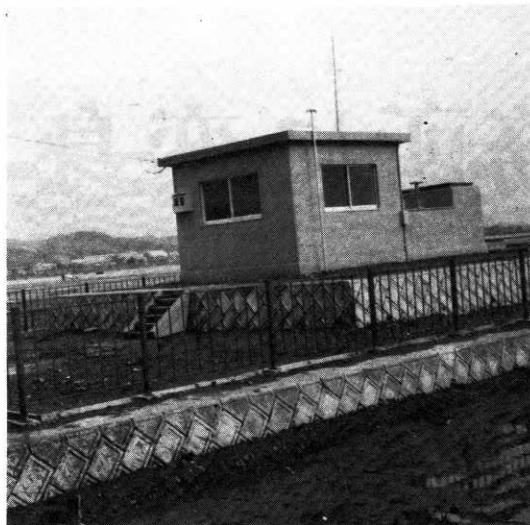
本 館 (着水井、浄水池、ポンプ室、管理室)
