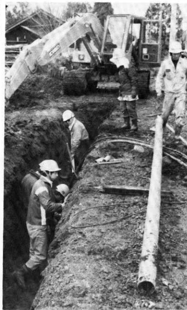
綴子簡水水道給水管埋設工事
