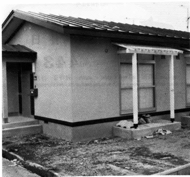
木造平家建住宅
