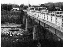
大野台と部落をつなぐ横測橋
