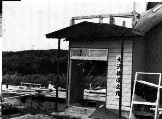
▲ 無惨にも全壊した大沢会館
