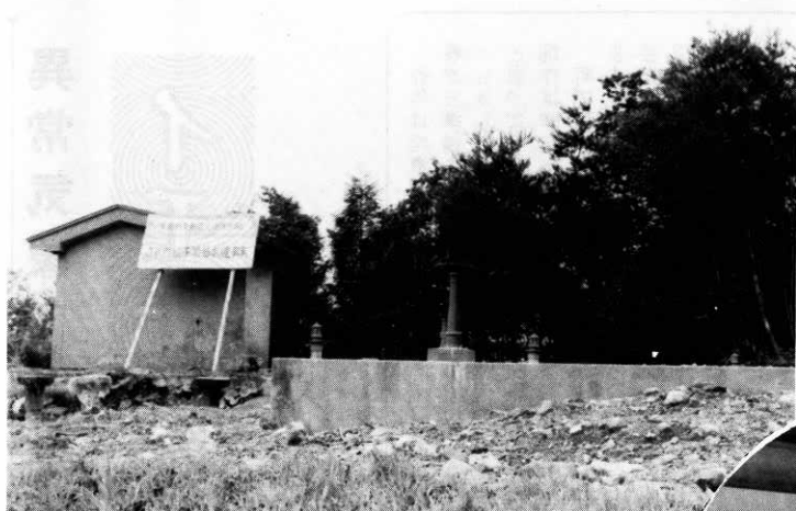
▲昭和の高台にある配水池
