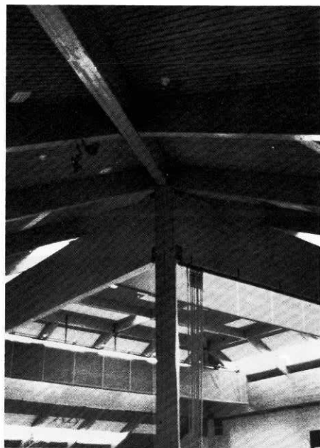
木材を利用した体育館
