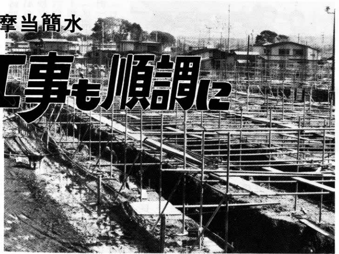
▲低学年校舎の基礎工事の型枠作業がまっ盛り(鷹巣小学校)
