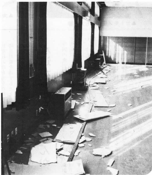
▲天井がはげ落ちた綴子基幹集落センター
