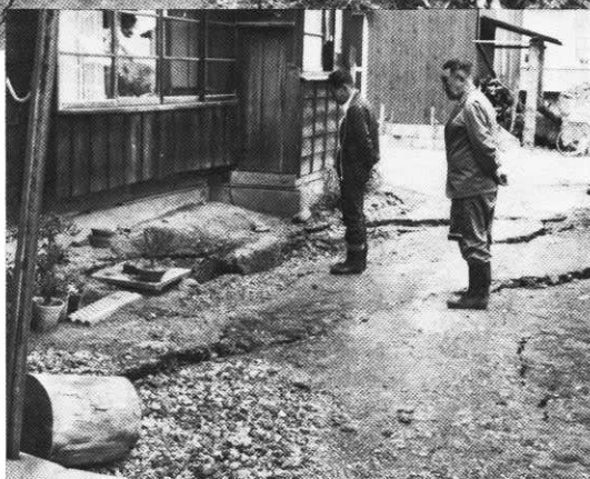
▲家の前が大きく地割れした（坊沢）
