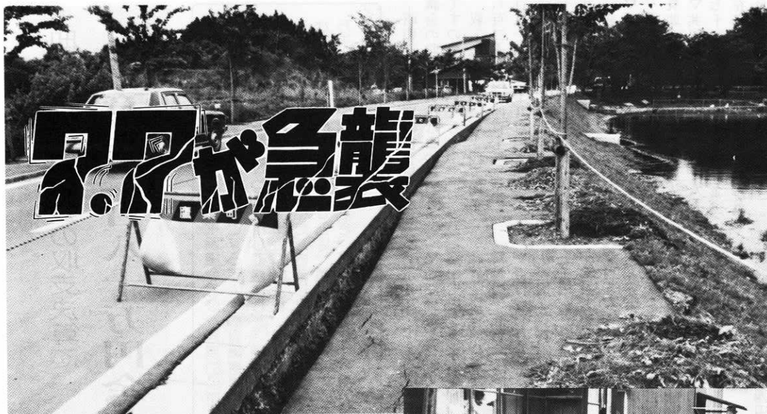
▲中央公園の歩道は百六十センチにわたって三十センチ位も陥没
