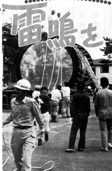
▶ヨコ綱をひと穴ごとに埋める 作業も大変な重労働
