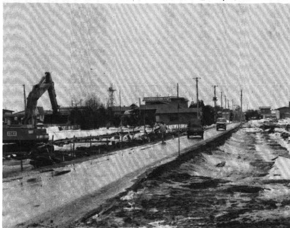
あけぼの町線の拡張工事
